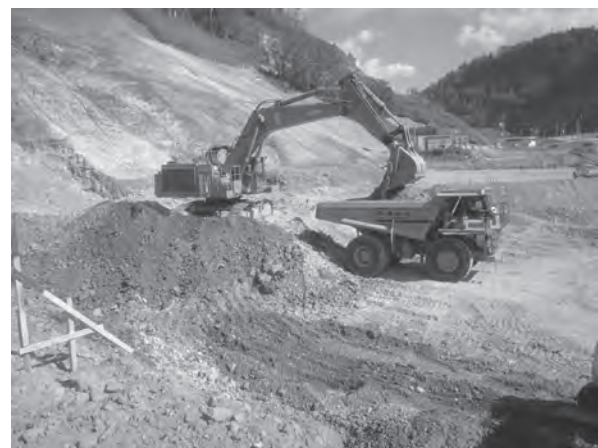
堤体基礎掘削状況
