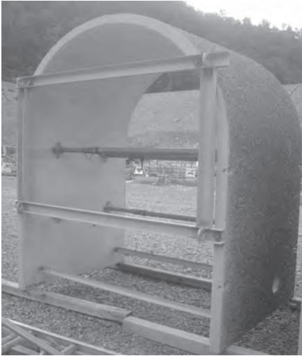
監査廊プレキャスト型枠
