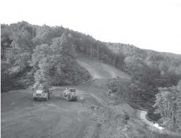
付替道々盛土状況
