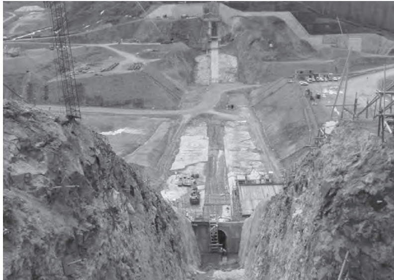
河床砂礫を残置したロック敷掘削状況（右岸→左岸）
