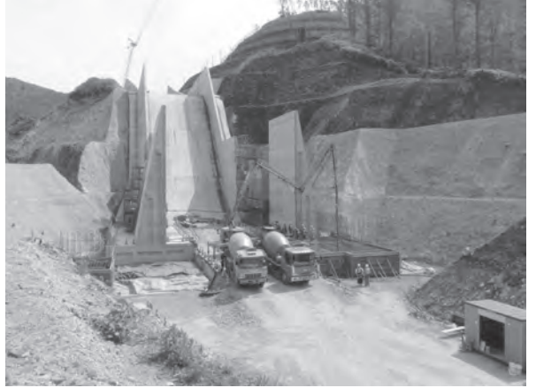
洪水吐減勢部コンクリート打設状況
