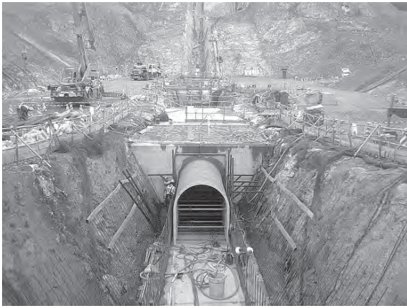
監査廊施工状況
