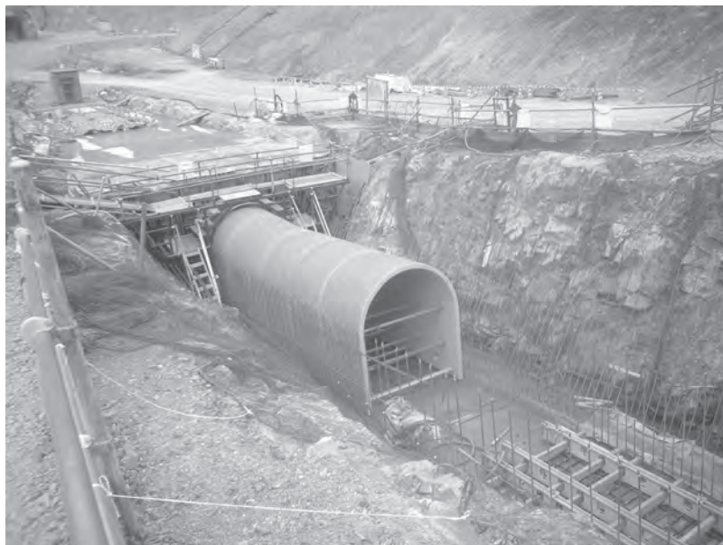
プレキャスト型枠設置完了
