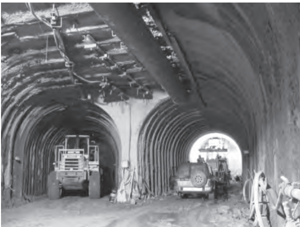
仮排水路・放流路トンネル合流部
