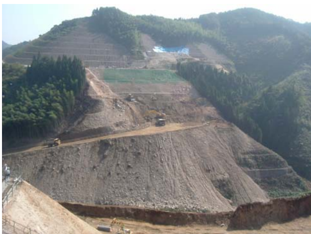
写真-2 基礎掘削状況
