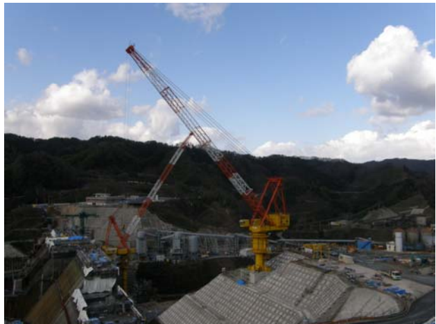
写真-13 左岸用打設設備 タワークレーン (13.5t×75m)
