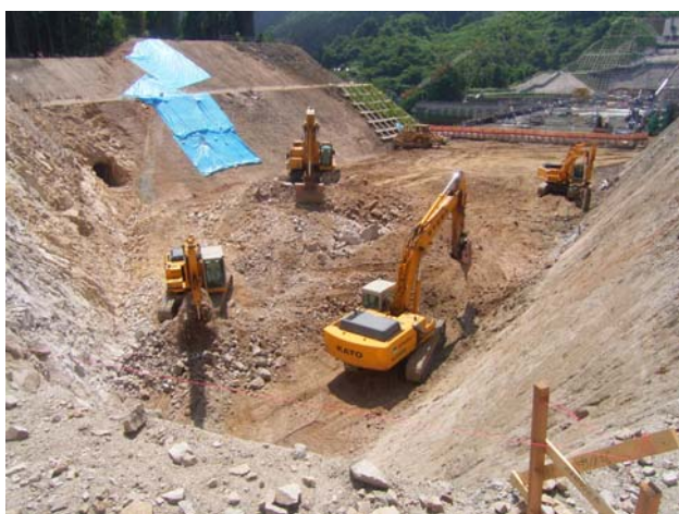
写真-5 左岸基礎掘削状況
