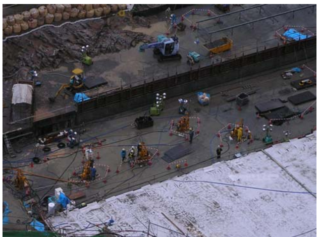
写真-11 基礎処理工施工状況
