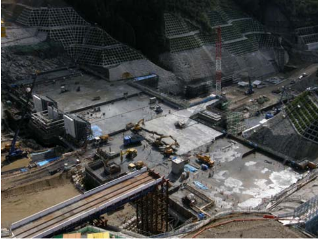
写真-6 本体コンクリート打設 (ダンプ直送)
