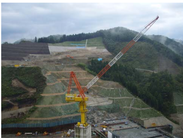
写真-4 左岸頂部掘削状況
