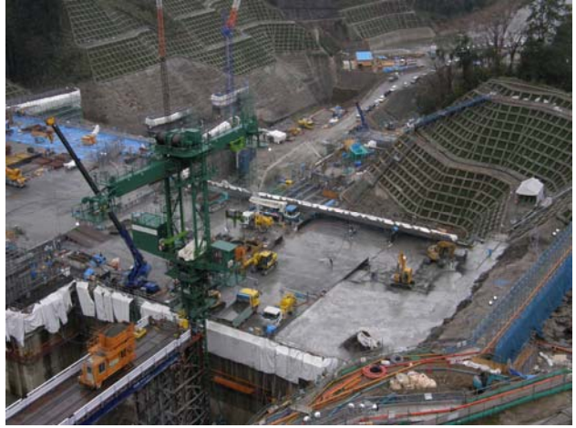
写真-7 本体コンクリート打設 (クレーン積み替え打設)
