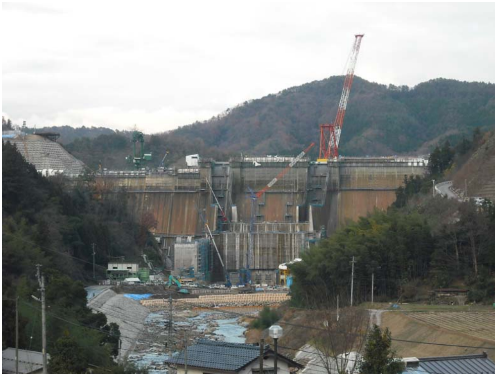
写真-1 堤体下流面（平成21年12月撮影）
