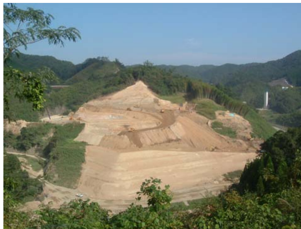
写真-3 仮設備ヤード造成状況
