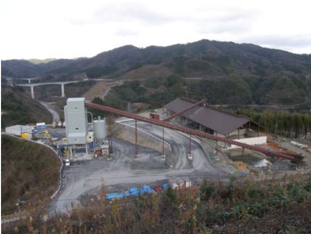
写真-12 左岸仮設備全景
