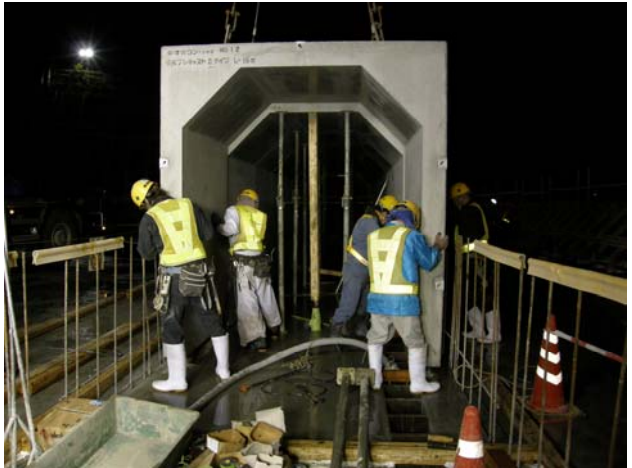
写真-9 プレキャスト通廊設置状況
