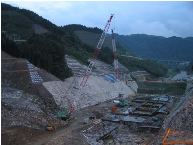
写真-8 減勢エコンクリート打設
