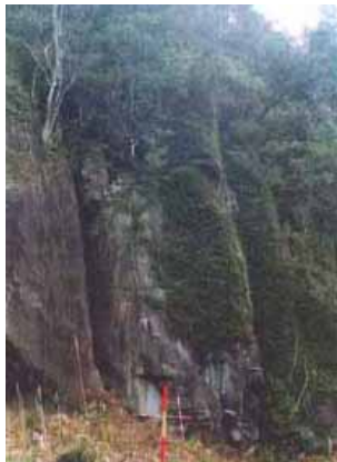
右岸上部不安定岩塊
