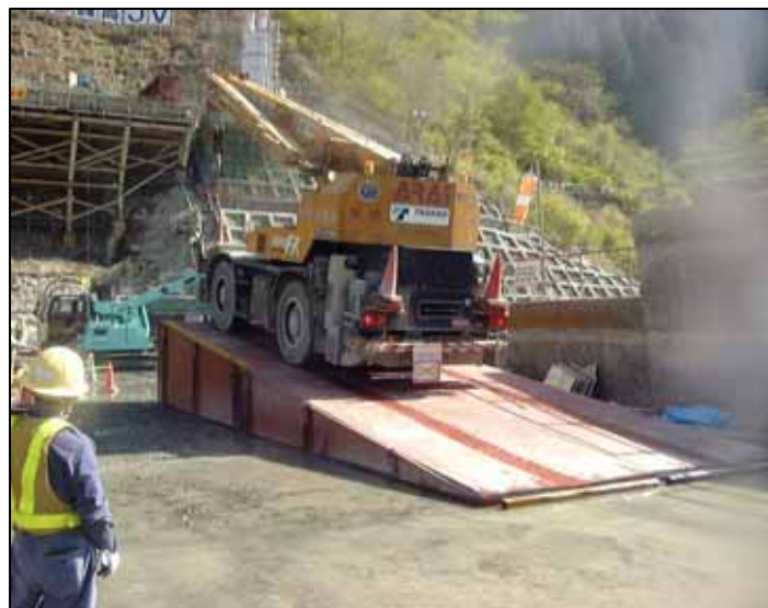
・写真 22 完成後試験状況
