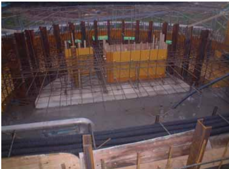
プレキャスト床版設置後、次リフト型枠設置状況 (大規模の開口を設置)
