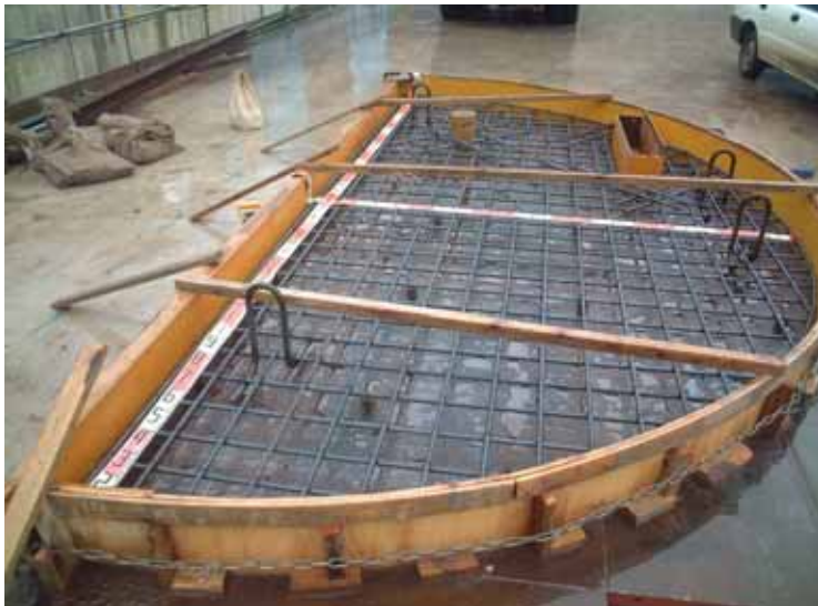
プレキャスト床版 製作状況 (小規模の開口のみを設置)
