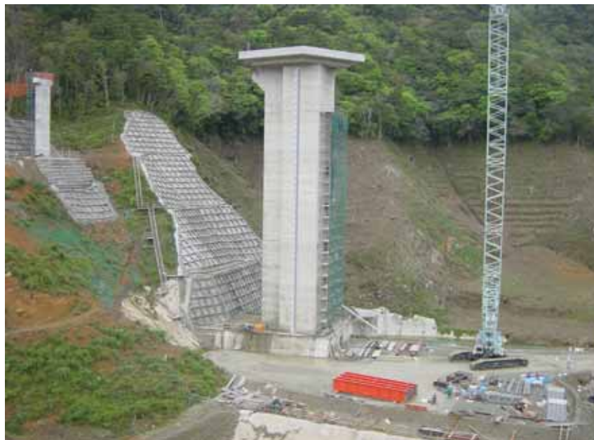
取水設備完了全景
