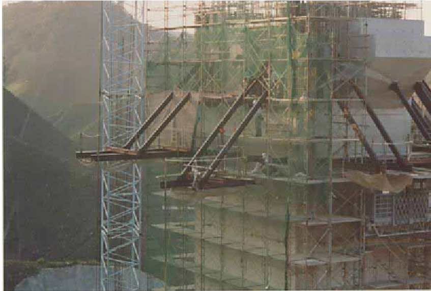
ブラケット設置状況
