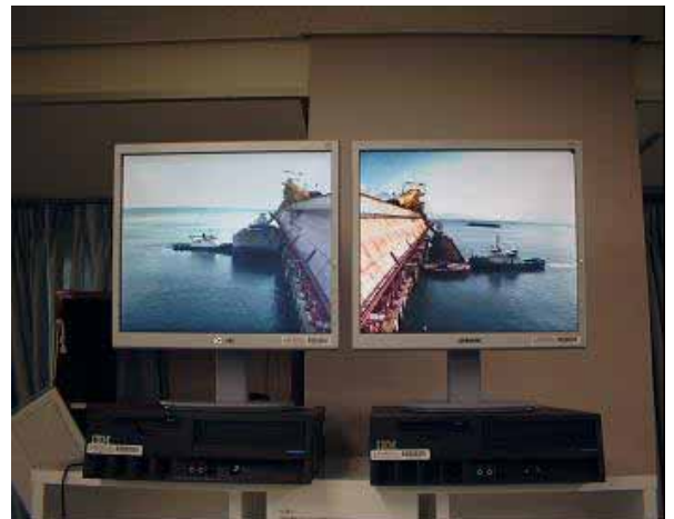
管理事務所 画像受信設備設置状況
