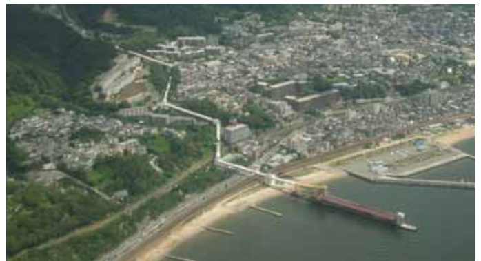
運搬棧橋全景
