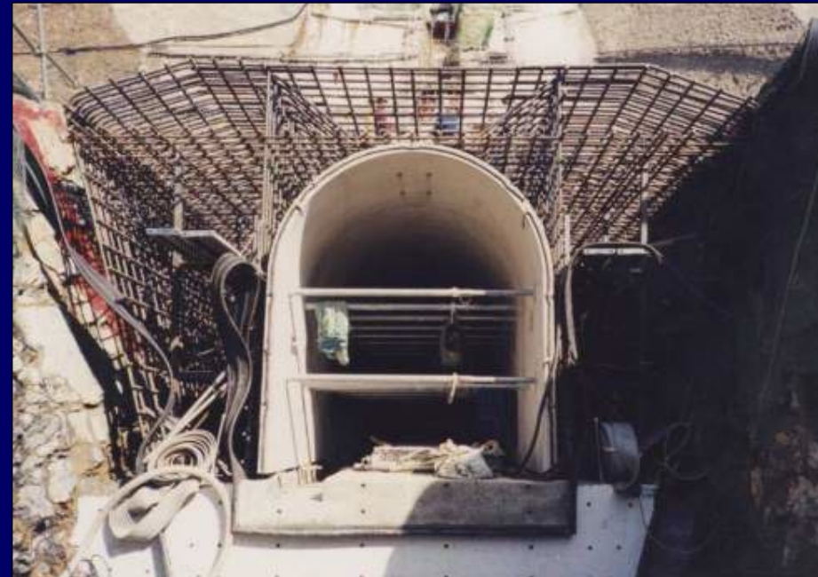
フィルダム通廊のプレキャスト型枠
