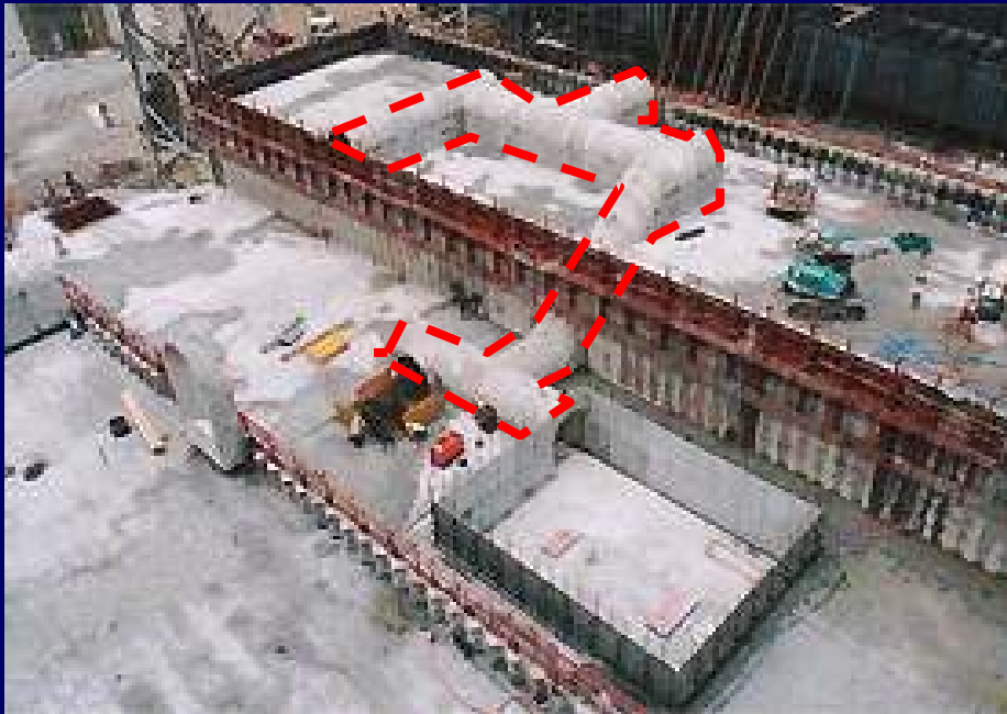
コンクリートダム通廊のプレキャスト化
